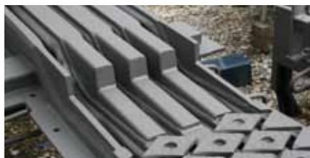
Guardarraíl de una junta de dilatación con aislamiento acústico
