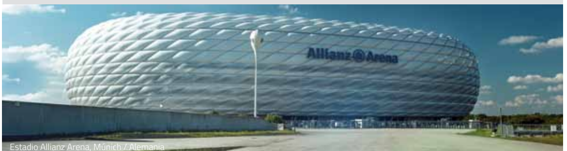
Estadio Allianz Arena, Múnich / Alemania
