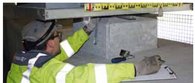
Inspección de los apoyos de un puente
