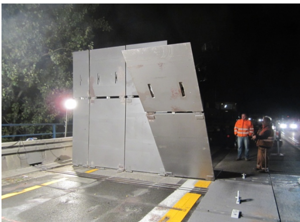
Abb. 3 - Vorbereitung der Nachtschicht
