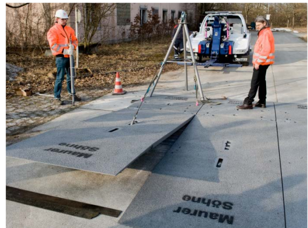
Abb. 2 - Öffnen mittels Winde und Dreibein
