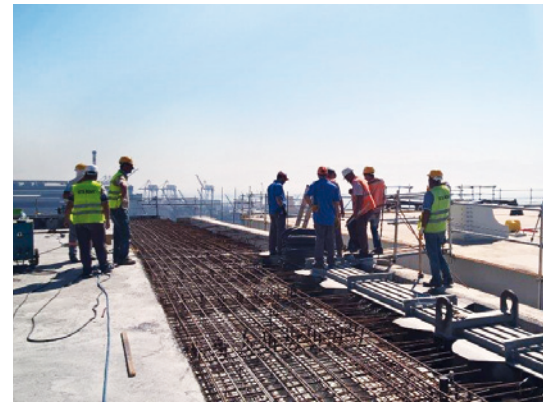
Einbau der 5-profiligen Dehnfuge an der nördlichen Auffahrt.
