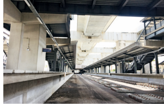
Eine der neuen Stationen im nördlichen Teil der ‚Red Line‘. Der Fotograf stand auf Straßenniveau, oben sichtbar die Red Line in Hochlage.
