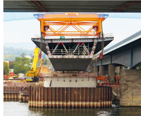
Hohlkastenbrücke im Bau, rechts die mittlerweile rückgebaute alte Schiersteiner Brücke.
