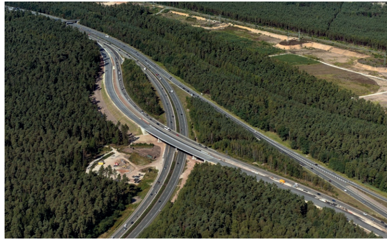
2 Luftbild: altes und neues Bauwerk © Hajo Dietz
