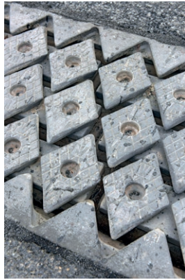
14 Lamellen der Schwenktraversen-Dehnfuge © Hajo Dietz
