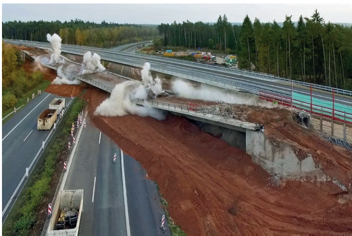
11 Sprengung des alten Bauwerks und ... © Hajo Dietz
