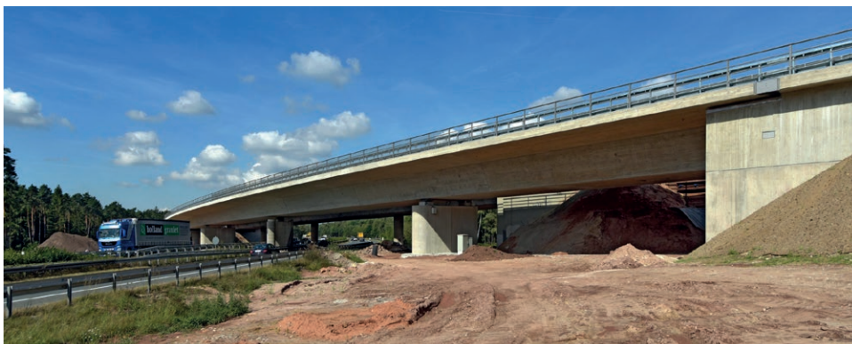
3 Intelligente Brücke mit sensorbestücktem Randfeld © Hajo Dietz
