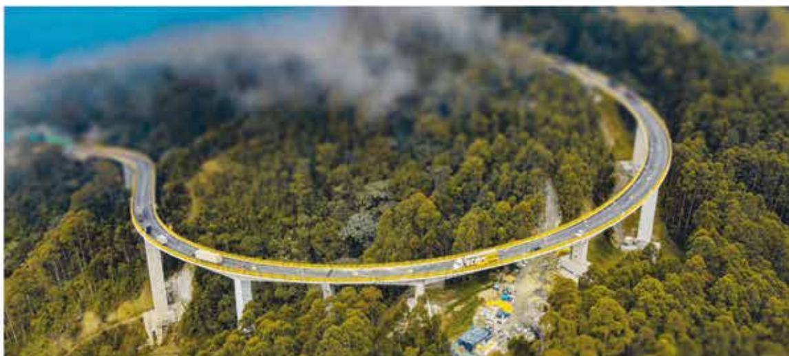
Das hufeisenförmige Yarumo-blanco-Viadukt in Kolumbien verkürzt die Fahrtzeit von Bogota an den Pazifik erheblich. Vorne rechts am Fuß des kurzen Pfeilers ist der Betonquader zu sehen, unter dem die nachträglich eingebauten Isolatoren liegen.
