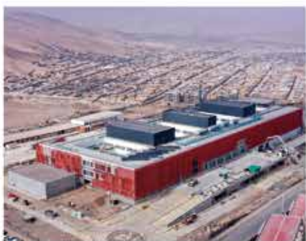
Das Klinikzentrum in Alto Hospicio im Mai 2021. Die Gebäudestruktur steht – komplett erdbebenisoliert.
