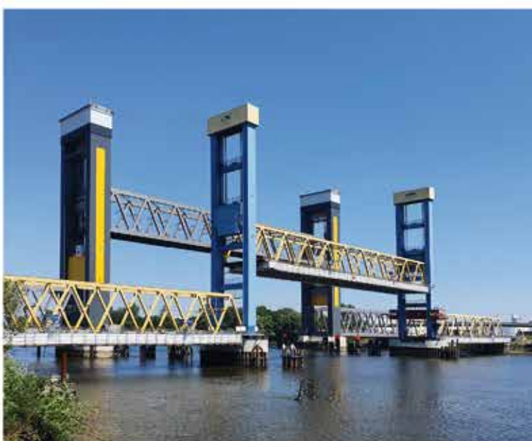
Die Kattwykbrücken im Hamburger Hafen: hinten die neue für den Bahnverkehr, vorne die 1973 errichtete, die nun nur noch den Straßenverkehr trägt.
